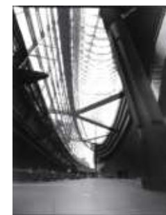
ロビーに露出を合わせると、天井が白飛びし、梁が写らなくなってしまいます。 (Fig2:ロビー)
