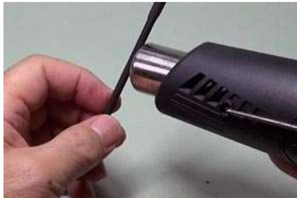
F-② ヒートガンで加熱し密着させる
